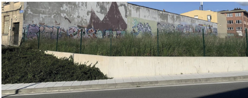
Muro de contención junto a la zona noroeste de la parcela (calle Eslovaquia)
