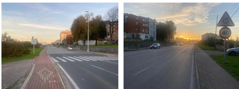
La Avenida de Los Castros en el contacto con el ámbito, en dirección este y oeste
