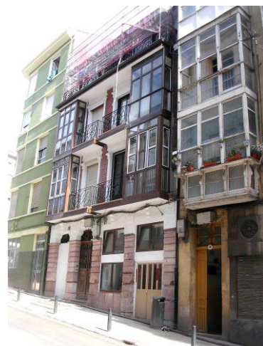
Edificio en calle Alta número 14
