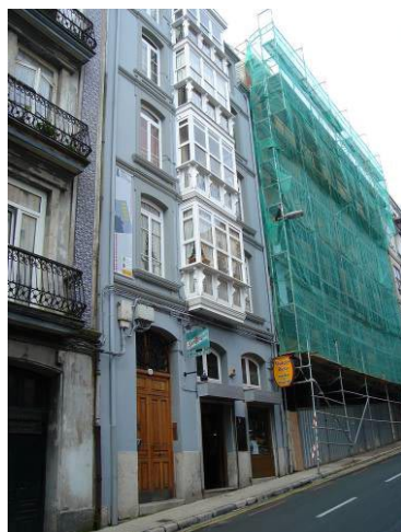
Edificio en calle Alta número 3
