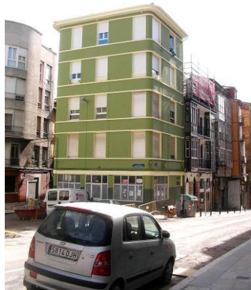
Edificio en calle Alta número 16
